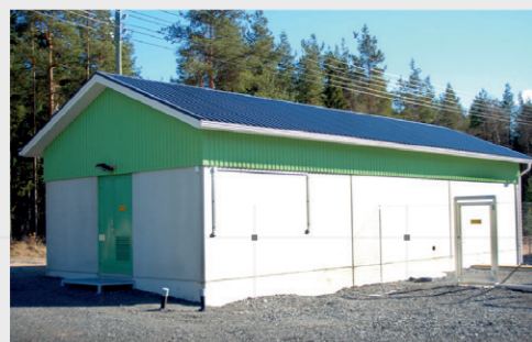
Teknikhus i betongkonstruktion med brandklass P1.
