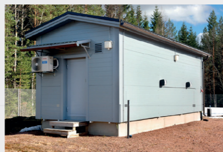
Teknikhus i stålkonstruktion med brandklass P2.
